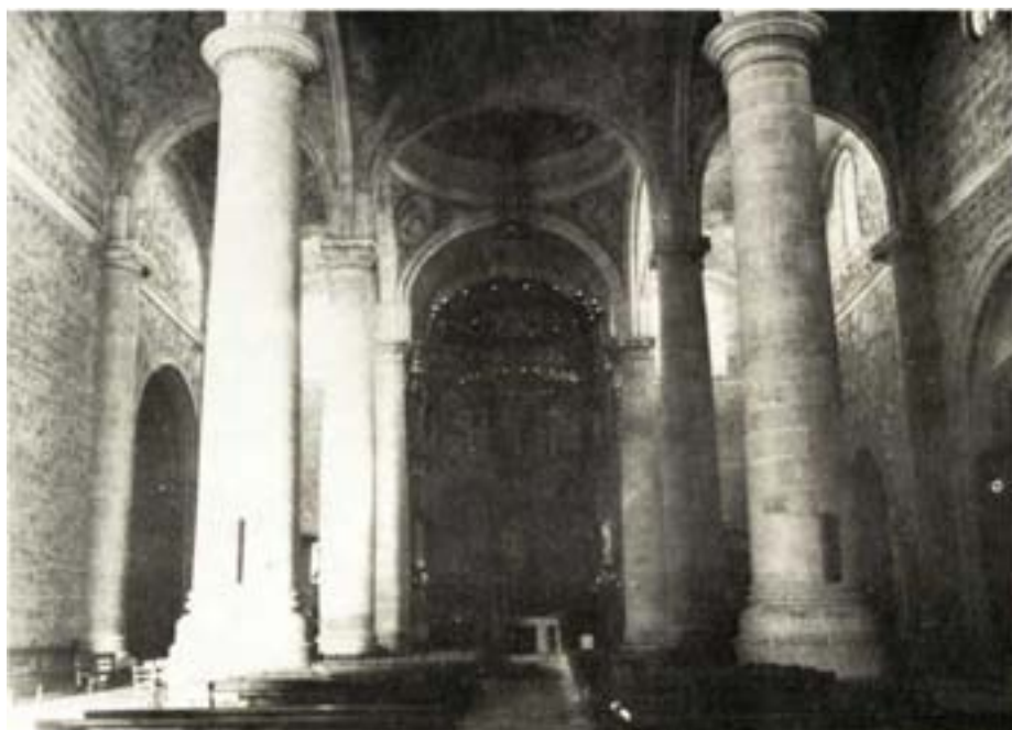
FOT. 2— LA RODA. Interior hacia lá cabecera.
