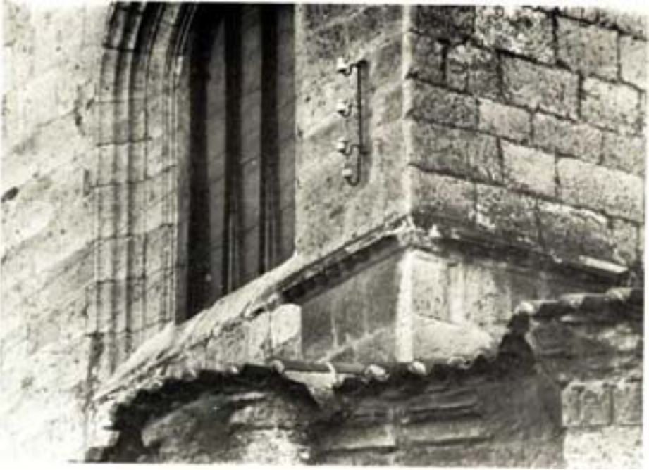
FOT.25—ALBACETE. San Juan Bautista. Decoración de pomas abulenses en un contrafuerte exterior del lado Norte
