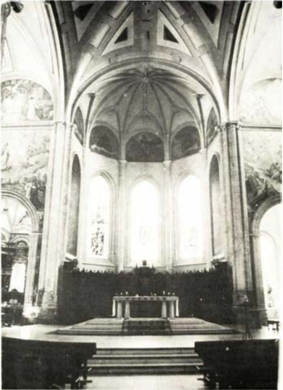
FOT. 17-ALBACETE. San Juan Bautista. Abside mayor.
