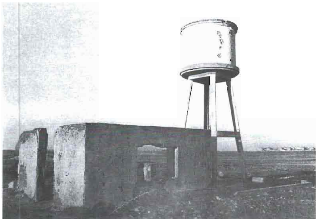
Detalle del depósito de agua del aeródromo de la Torrecica.
