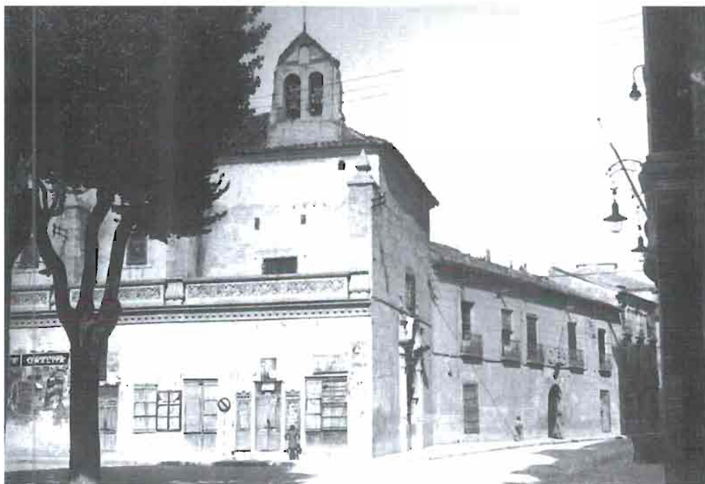
Fotografía 2. Fachada y lateral de las Justinianas.
