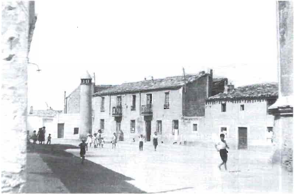
Vista de un respiradero de los refugios antiaéreos situado en el Alto de la Villa junto al depósito del agua, desaparecido con la construcción de Villacerrada.
