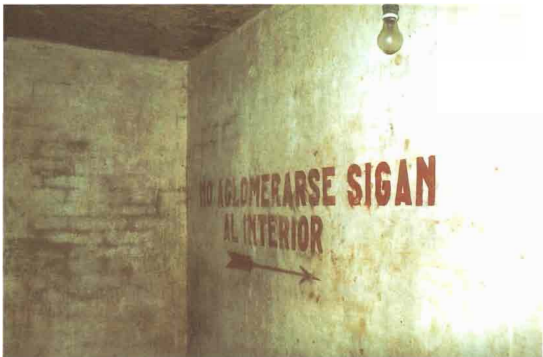
Interior del refugio del Altozano, en 1999.
