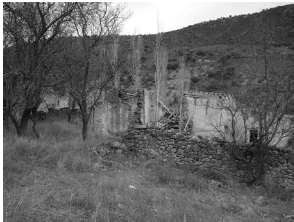
Ruinas de Los Marines. Estado actual
