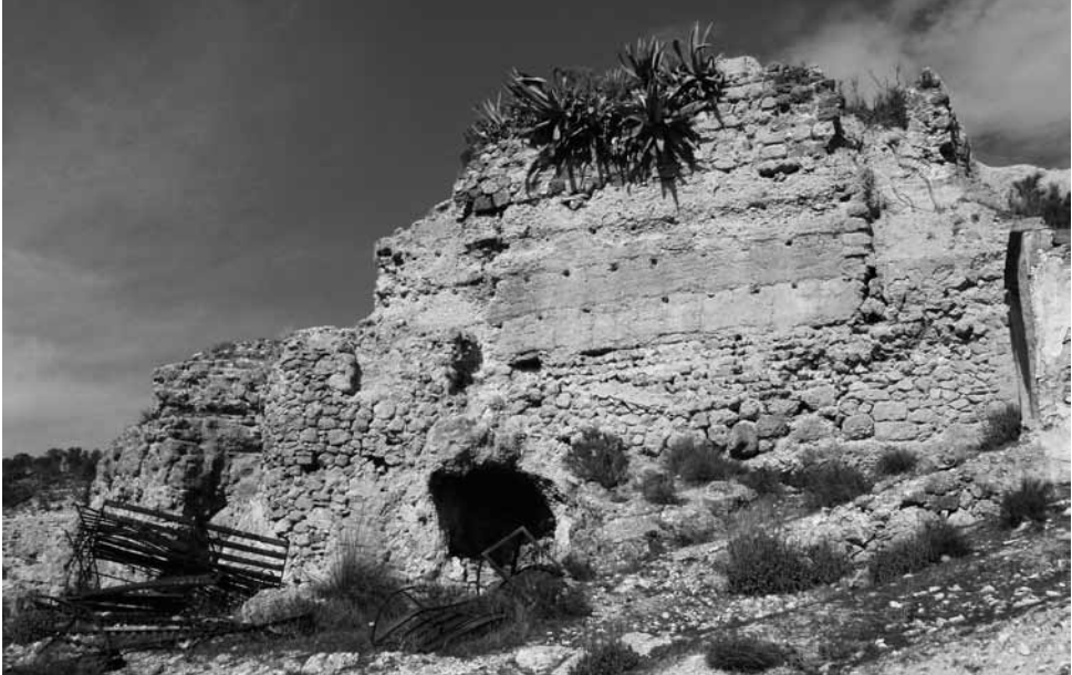
Ves: muralla almohade sobre el muro anterior
