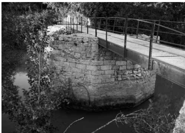
Puente Torres: pilar de un antiguo puente
