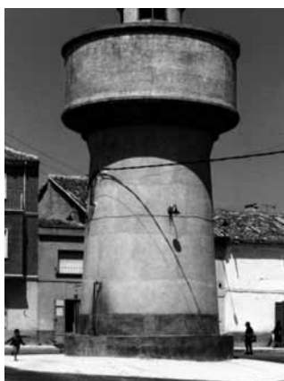
Depósito de agua en Mahora
