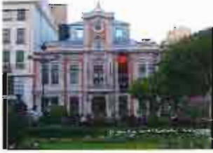
El arquitecto Martínez Villena reforma el edificio del ayuntamiento en la Plaza del Altozano, inaugurándose el año siguiente
