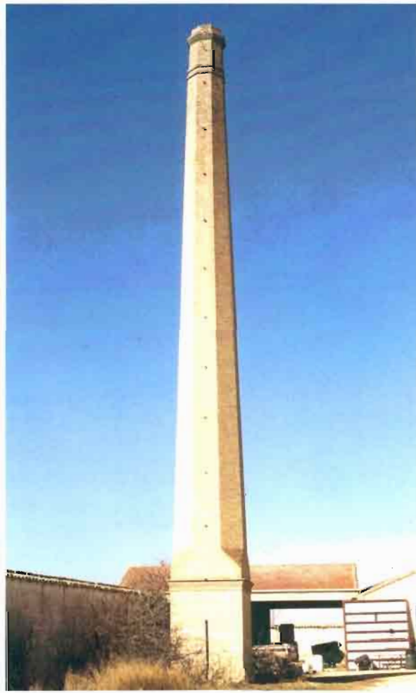
Fot. 43.- Madrigueras. Chimenea industrial
