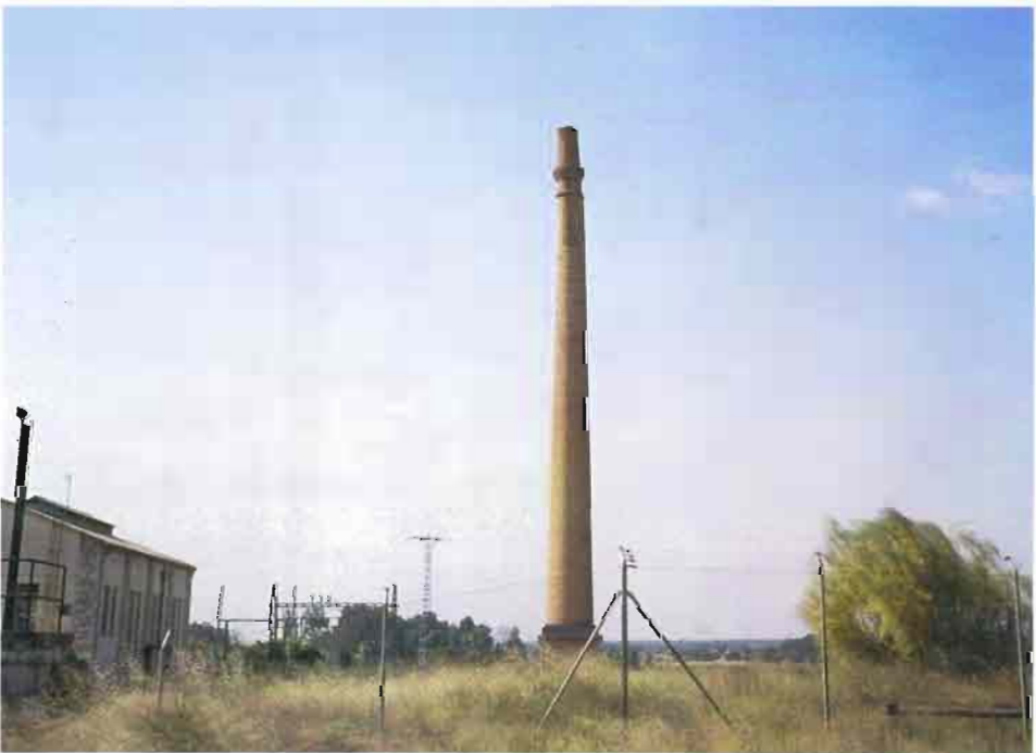
Fot. 60.- Fuensanta. Chimenea industrial. Fábrica de Papel
