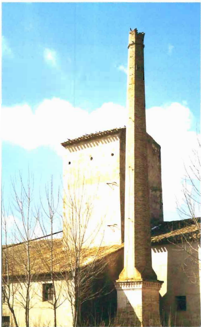
Fot. 16.- Alborea. Chimenea industrial
