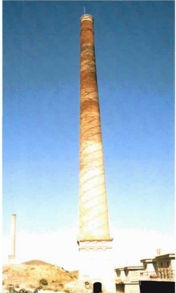
Fot. 31.- Hellín. Chimenea industrial
