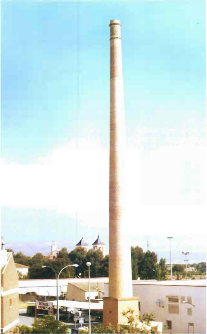
Fot. 19.- Almansa. Chimenea industrial
