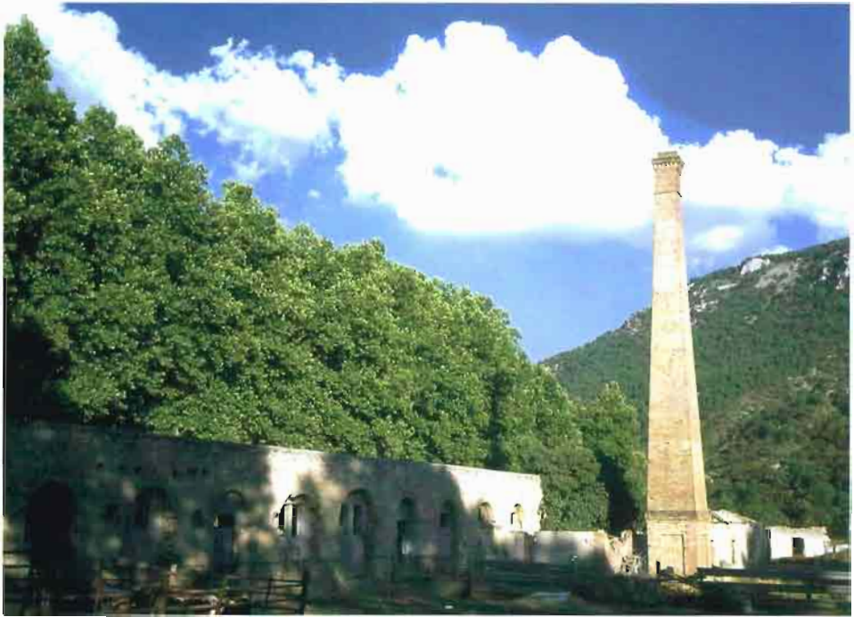
Fot. 69.- Riópar. Chimenea industrial. Reales Fábricas de San Juan de Alcaraz.
