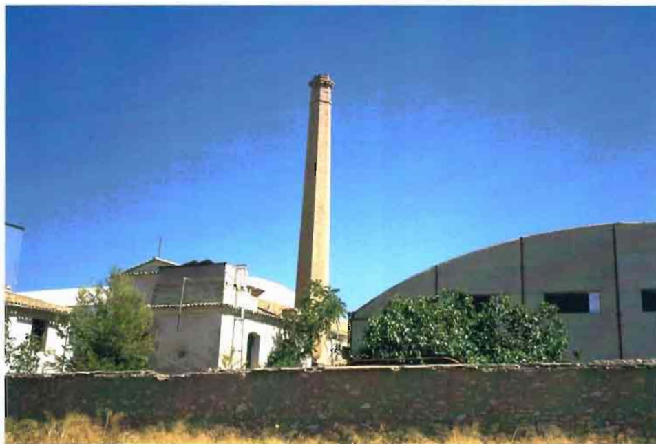
Fot. 63.- Hellín. Chimenea industrial. (Actividad desconocida)
