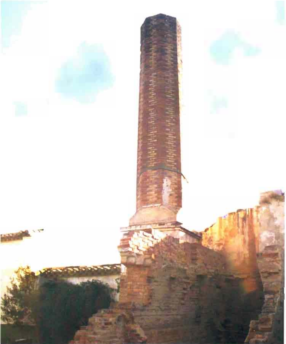
Fot. 27.- Casas Ibañez. Chimenea industrial
