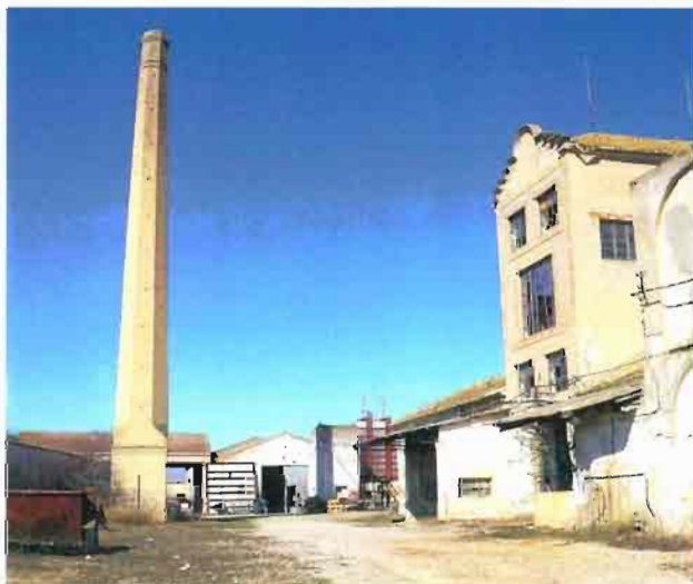
Fot. 68.- Madrigueras. Chimenea industrial. Fábrica de Alcohol de Luis Merino
