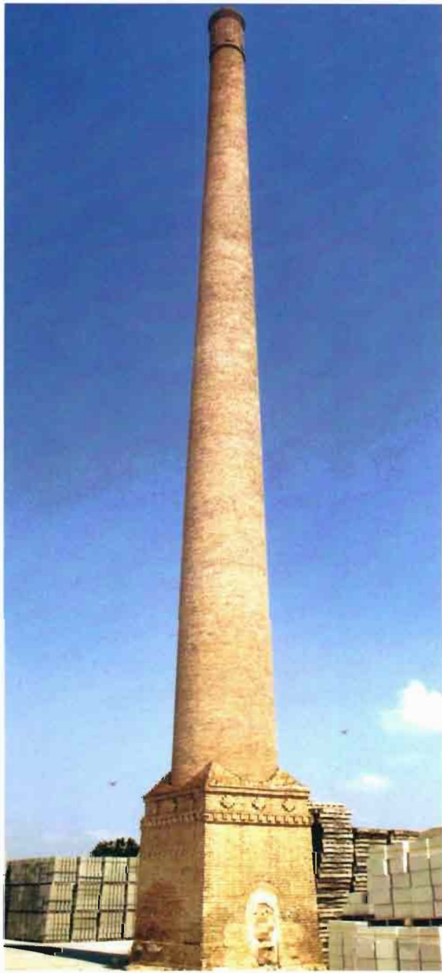
Fot. 40.- La Roda. Chimenea industrial
