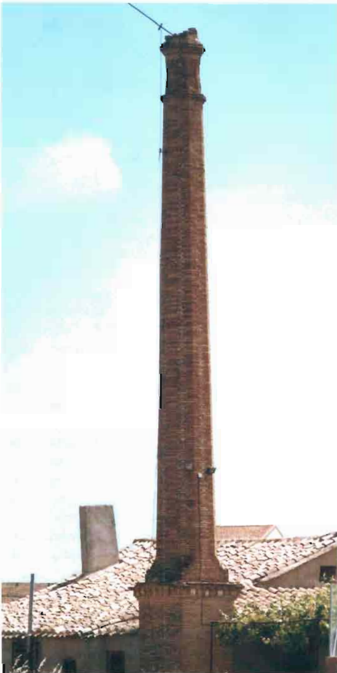
Fot. 38.- La Roda. Chimenea industrial
