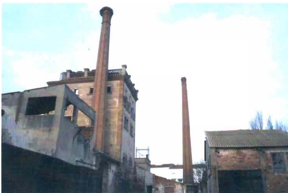
Fot.72.- Villarrobledo. Chimeneas industriales. Vinumar.
