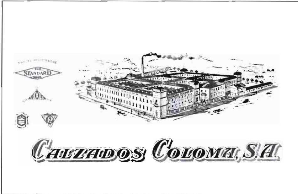
Fot. 51.- Almansa. Chimenea industrial. Fábrica de Calzados Coloma
