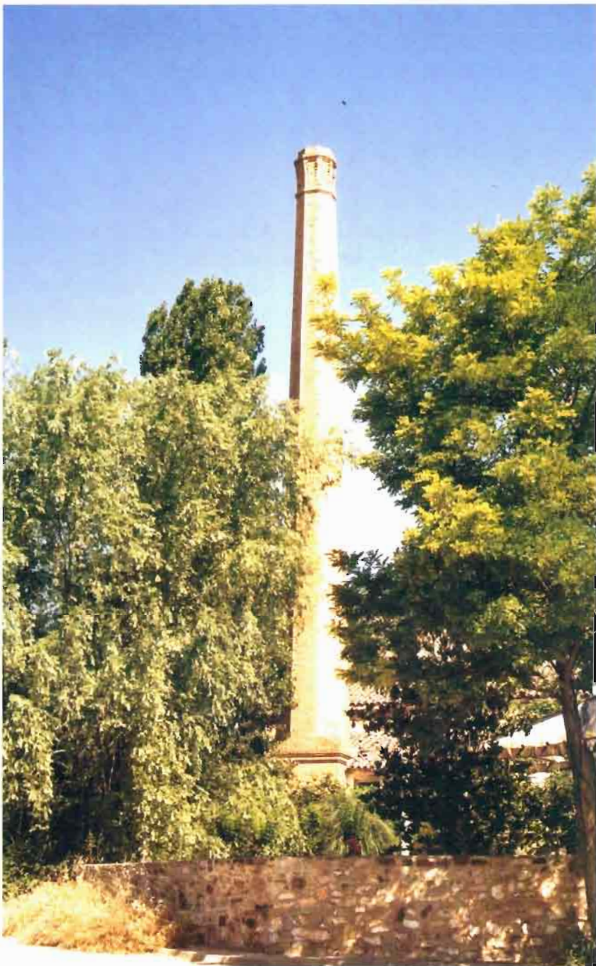
Fot. 23.- Bienservida. Chimenea industrial
