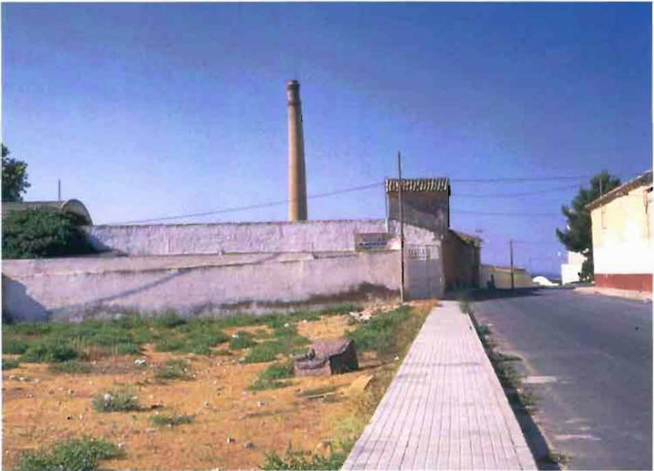
Fot. 62.- Hellín. Chimenea industrial. Fábrica de Aceites y Derivados (I.a Chispera)
