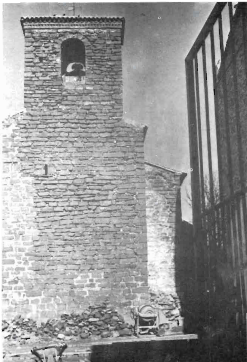
Torre de la iglesia.
