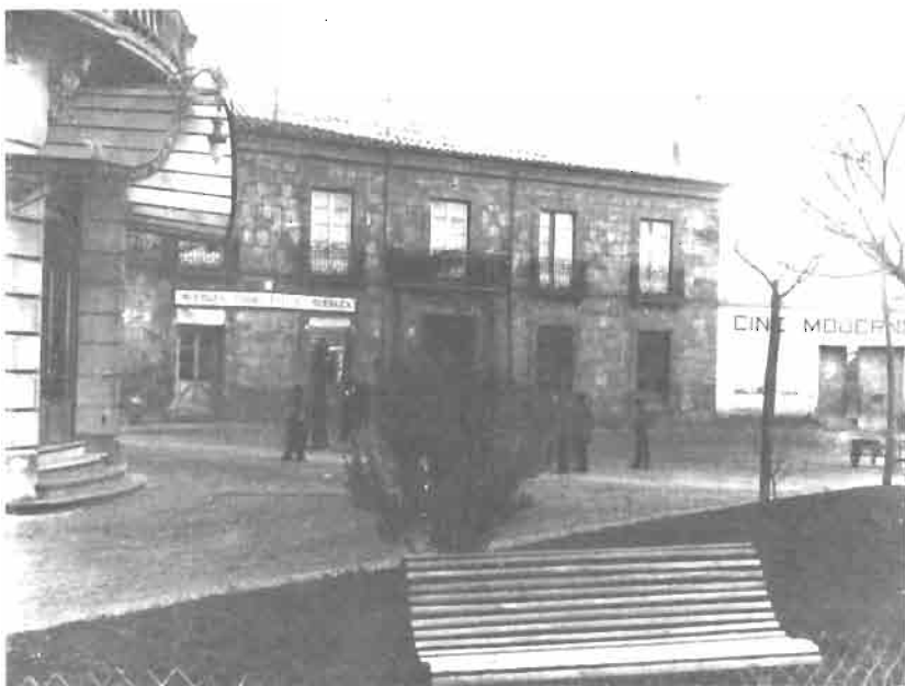
La casa del Conde de Villaleal, en el antiguo Altozano, que sirvió de alojamiento al rey. Estaba emplazada en el lugar que hoy ocupa el Banco Central, y fue demolida en el año 1920.
