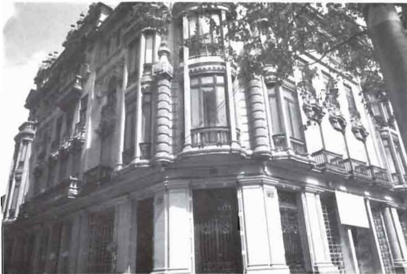
Casa nº 13, Paseo José Antonio (Banco Exterior)
