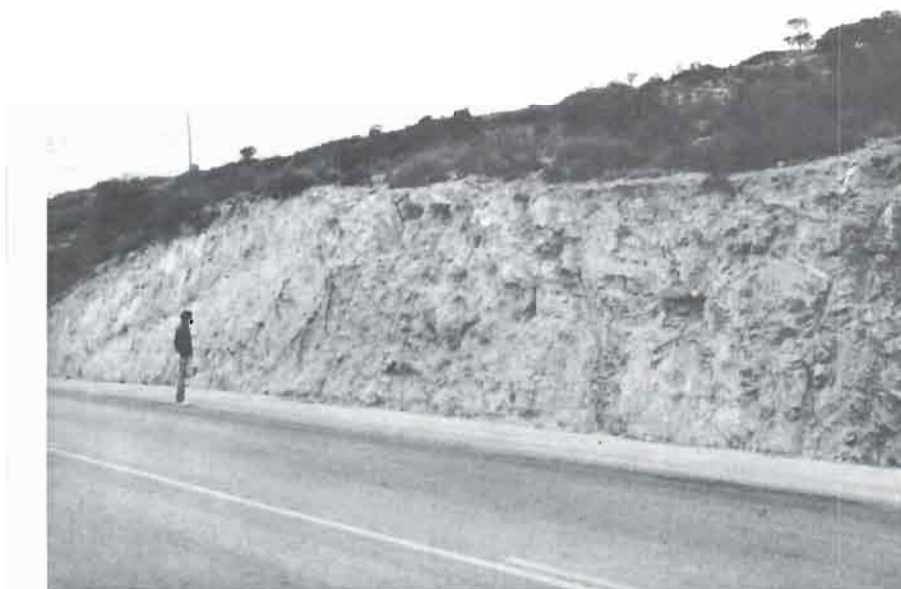
Foto n.º 8: Niveles competentes del Lías inferior-medio fuertemente levantados por los niveles arcillo-margosos del mismo término.
