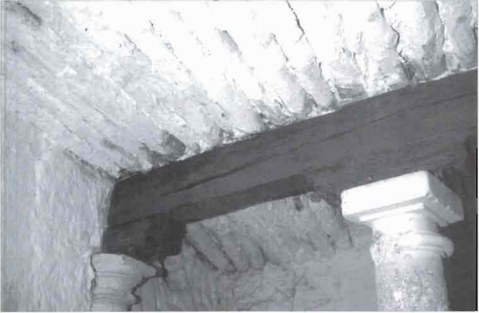
Letur. La madera utilizada en construcciones antiguas sirve para extrapolar los árboles disponibles y su calidad en aquella zona.
