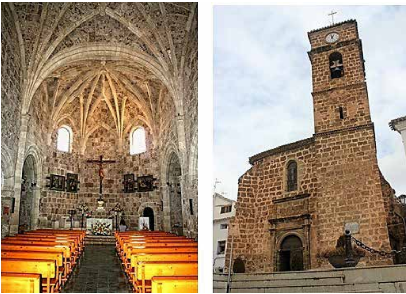
Fig.1 Iglesia parroquial de la Asunción de Letur (cabecera y exterior del edificio).
