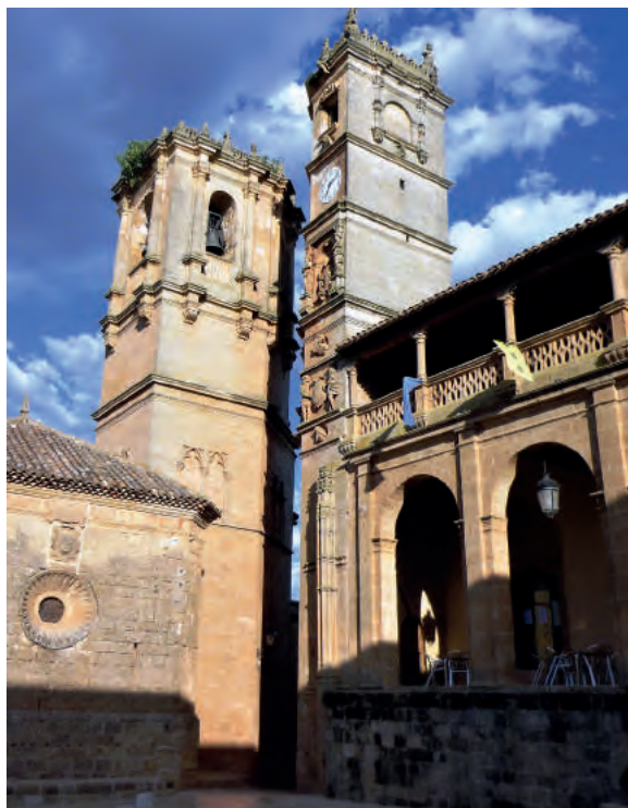
Las torres del Reloj y de la Trinidad, de las cuales la última parte de un cuerpo gótico (el resto todavía no estaba construido).
