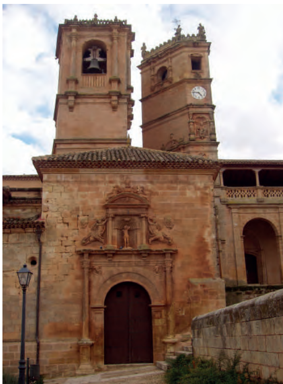
La capilla, costeada por el Ayuntamiento como obra concejil independiente y antepuesta a la torre y a la iglesia.
