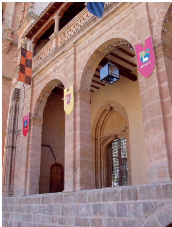
El rincón de la torre, con las puertas de acceso a esta y al convento.
