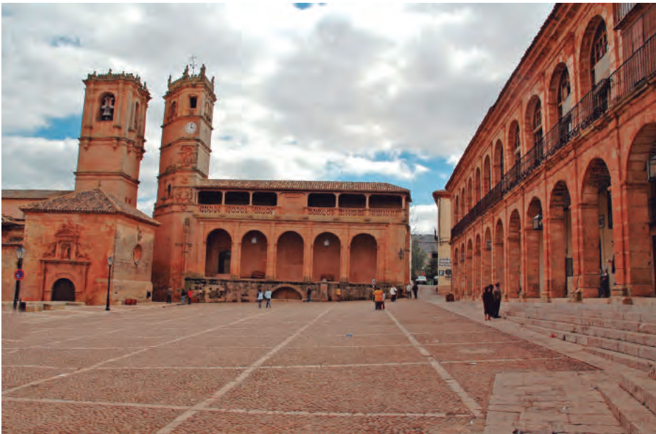
La plaza de Alcaraz: la capilla, las torres, la lonja y los portales de las Carnicerías y la Regatería.
