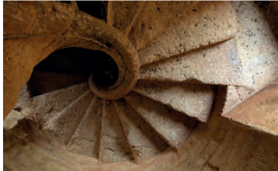
Caracol de Mallorca en el Libro de Trazas de Alonso de Vandelvira y en la Torre del Reloj de Alcaraz.
