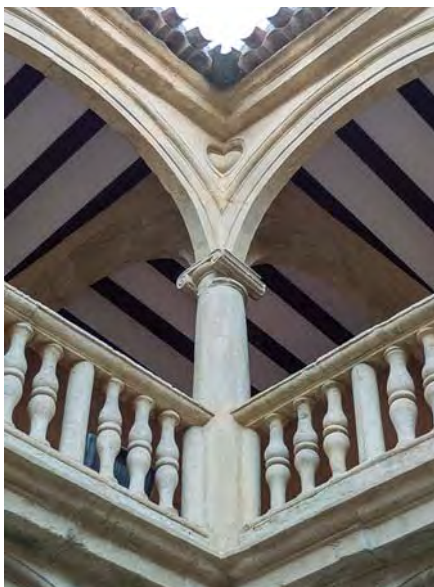
[6.16.] Esquina del patio de la Casa Grande en la que se percibe la solución del giro del capitel esquinero.
