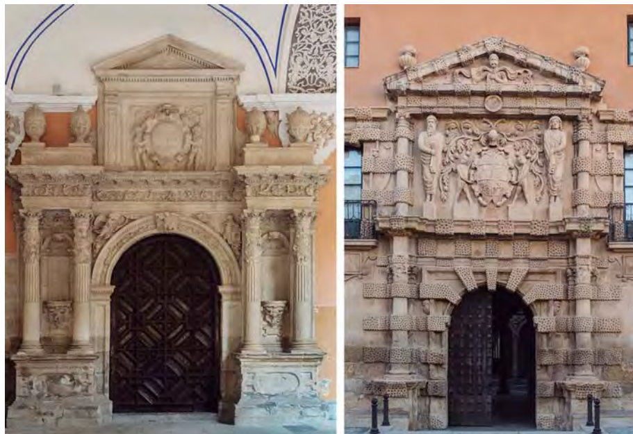
[5.11.] Comparación entre la portada de la sacristía del Convento de Santo Domingo de Orihuela y la Casa Grande almanseña.
