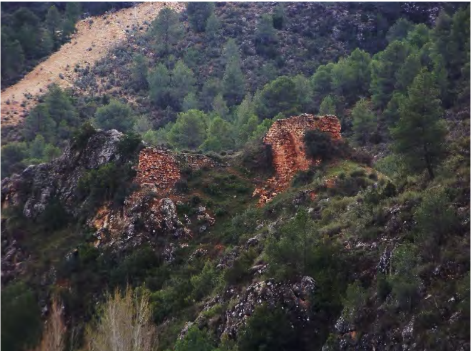
Ilustración 9. Vista de la cara norte de la fortificación de Híjar. © Fotografía del autor.
