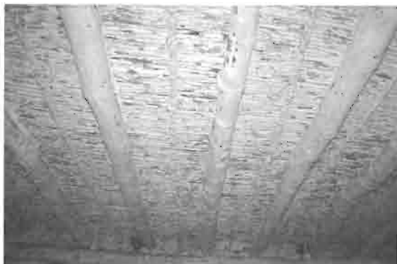
Detalle de la cubierta.
