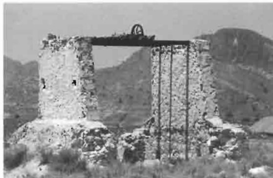
Vista de la situación actual de uno de los pozos.
