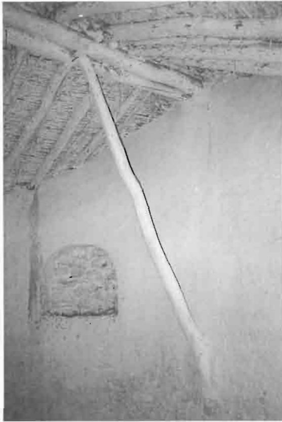
Detalle de la cubierta.
