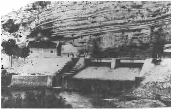
AZUFRERA DEL COTO DE HELLÍN: FRAMJE REGALADOR, VERTEDERO DE SUPERFICIE
