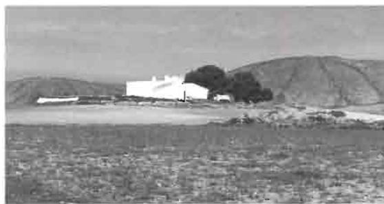
Vista general. Fachada lateral sur.
