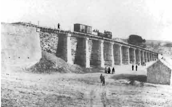
AZUFRERA DEL COTO DE HELLÍN VIADUCTO DEL FERRO-CARRIL. MIMERO
