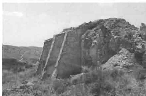
Vista actual de los restos de antiguos hornos de fundición.
