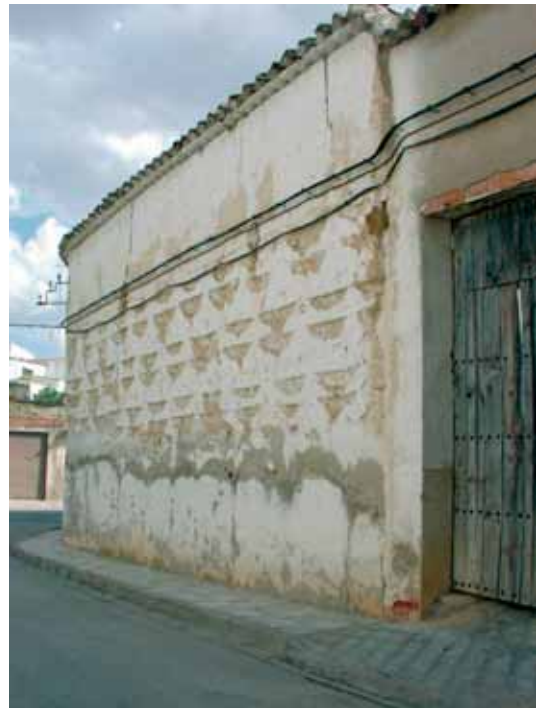
Curioso ejemplo de tapia con brecas que parece responder a un patrón similar al del esquema, en el que en cada tapia aparecerían cuatro lunetos. (Tarazona)
