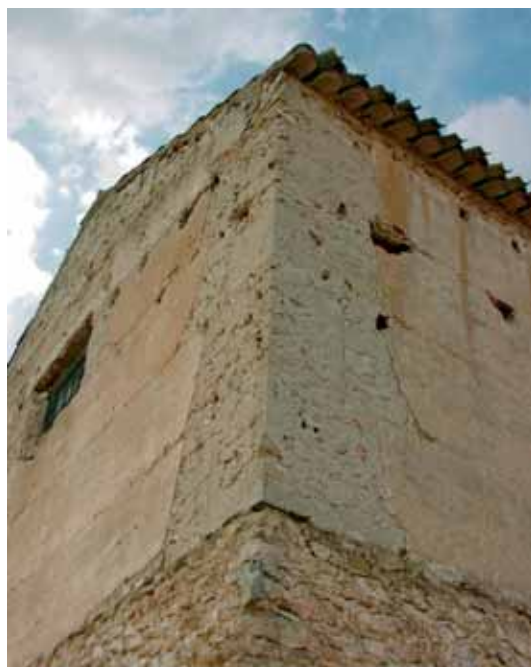
Tapiales reforzados con breccas en esquina. Casas de Juan Núñez (izquierda) y Fuensanta (derecha)
