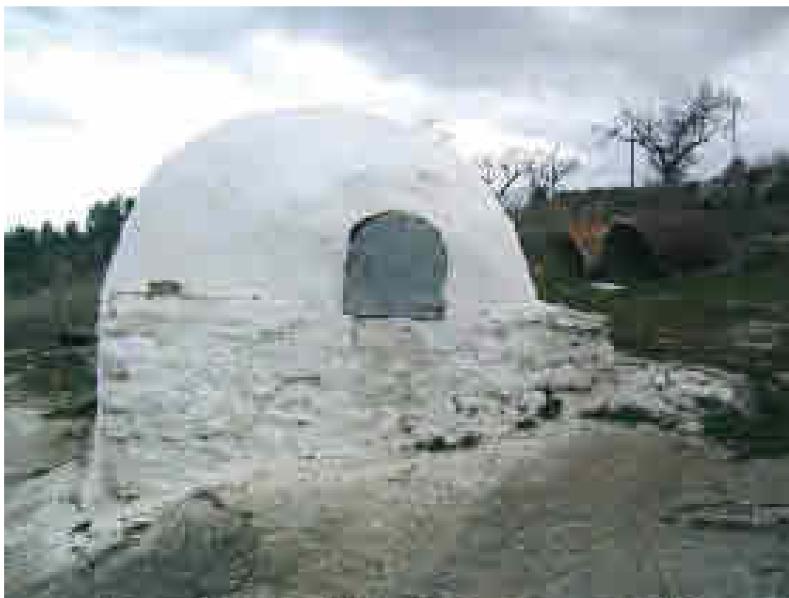
Horno en Juan Quiles (Yeste). En forma de cúpula y encalado y peana de mampostería sobresaliendo
