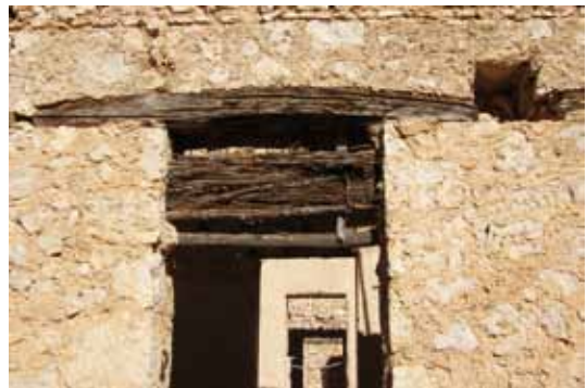
Persiana realizada con arbustos secos y esparto. Casa de la Central de La Recueja.
