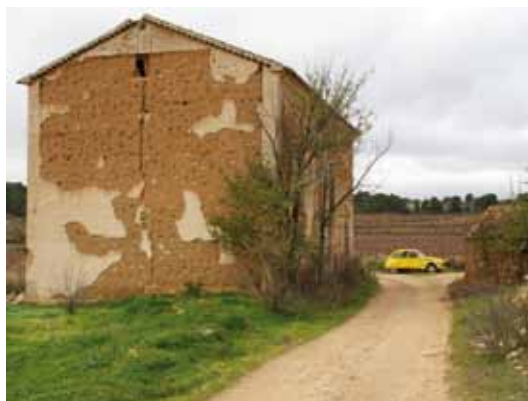
Casa de Gabaldón. Término de Villalpardo. Espectacular tapia de unos once metros de altura
