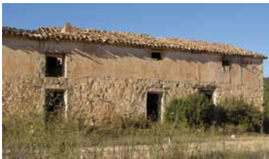
Fachada sur de la vivienda. Acceso a la cuadra y a la vivienda
