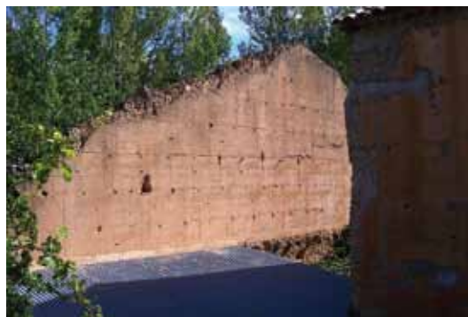
Venta de Vadocañas. Tapia del siglo XVI. Pueden verse las juntas del tapial y los huecos de las agujas
