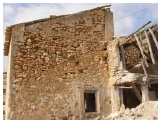
Muro de mampostería. Sobreelevación posterior. Aldea Puente Torres.
