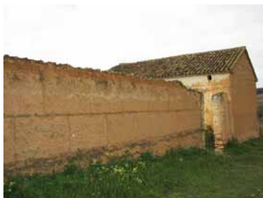
Tapia sobre zócalo de mampostería. Aldea de los Nuevecillos. Término de Alarcón
