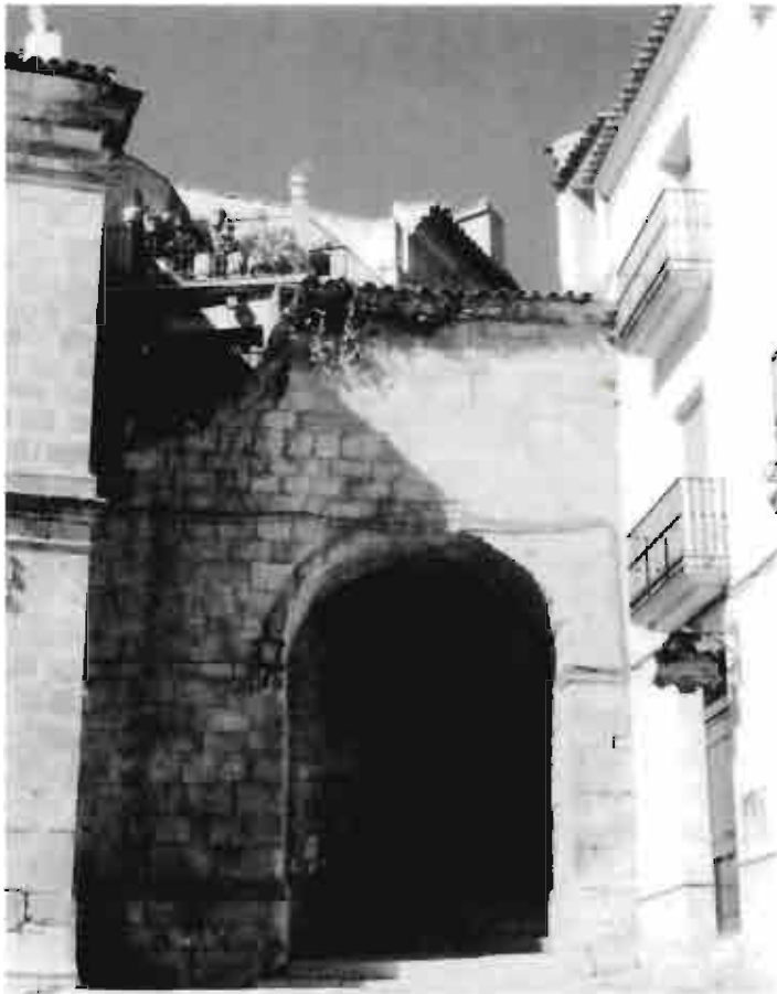
Foto 3.- Arco de la Zapatería y mirador de las monjas (la terraza superior es una construcción reciente)
