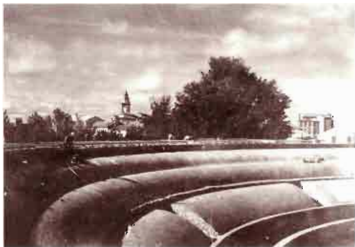
La Plaza de toros en plena construcción. Puede verse las bóvedas que conformarán los asientos de los graderíos y los vomitorios
