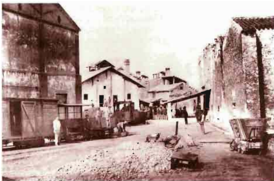
Azufrera del Coto de Hellín. Vista parcial de la fábrica
