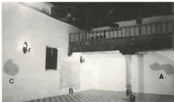
Foto 1.- Interior de la ermita, parte posterior
