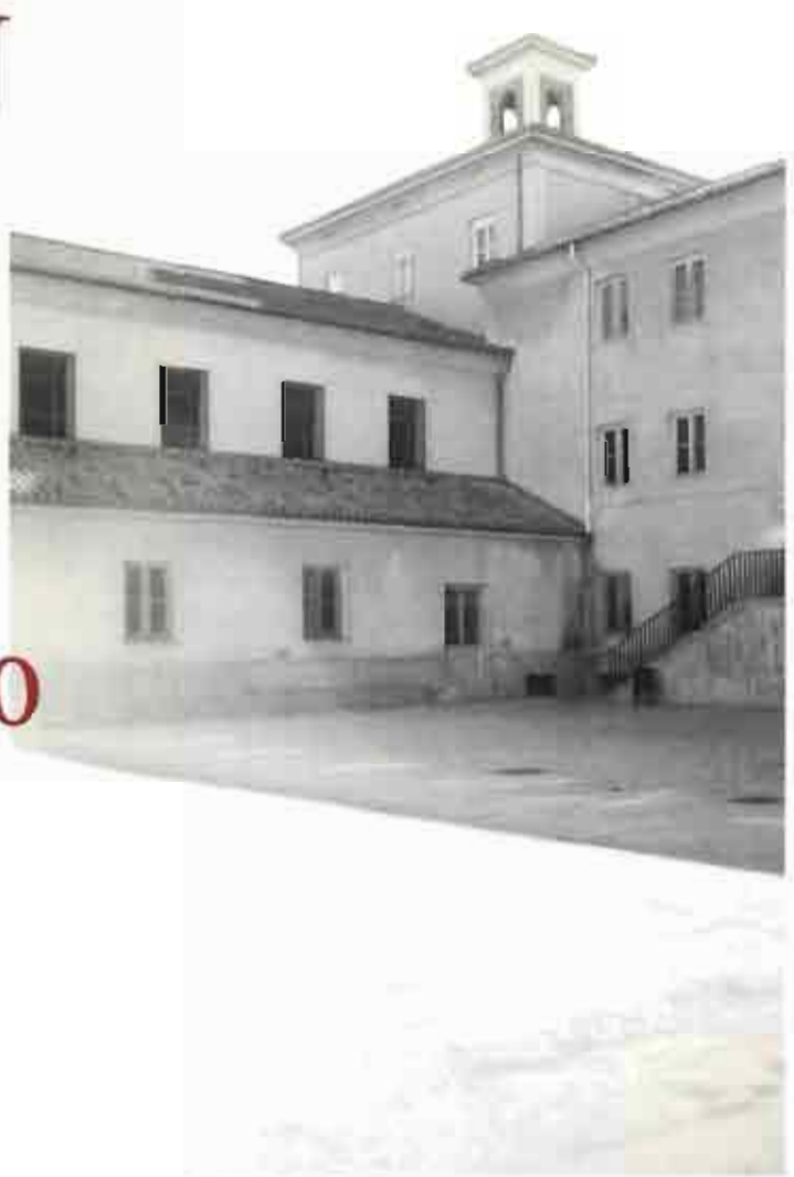
Centro "Giner de los Rios". La Capilla, actual Salón de Actos, desde el patio. (Foto de la autora)
