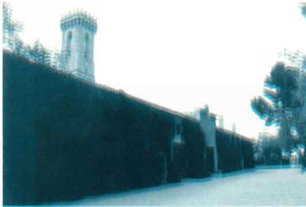
Fachada donde se encontraba la antigua ermita y convento. Estado actual.
