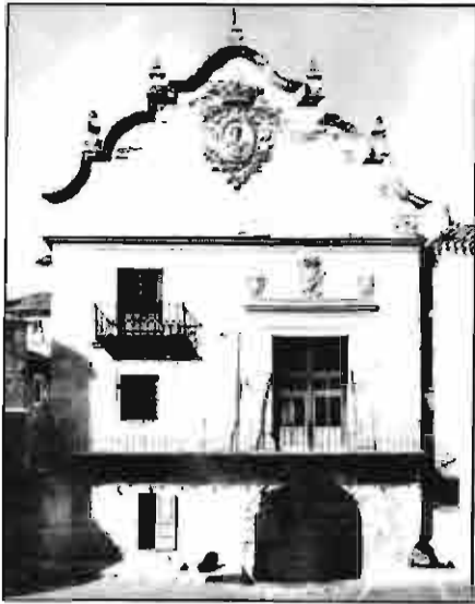
Fachada barroca del Ayuntamiento, (S. XVI).
