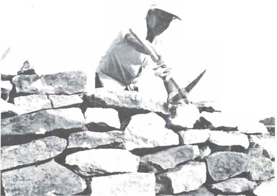
FOTO 88. Basilio “levantando” un muro de mampostería en seco a golpe de piqueta.
