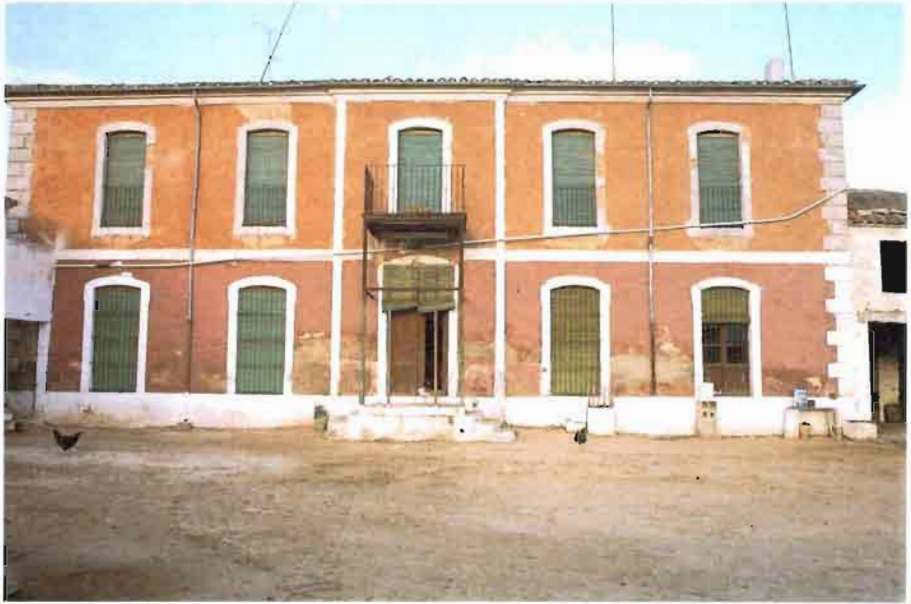
FOTO 79. Vista de la fachada principal de la Casa Colorá.
