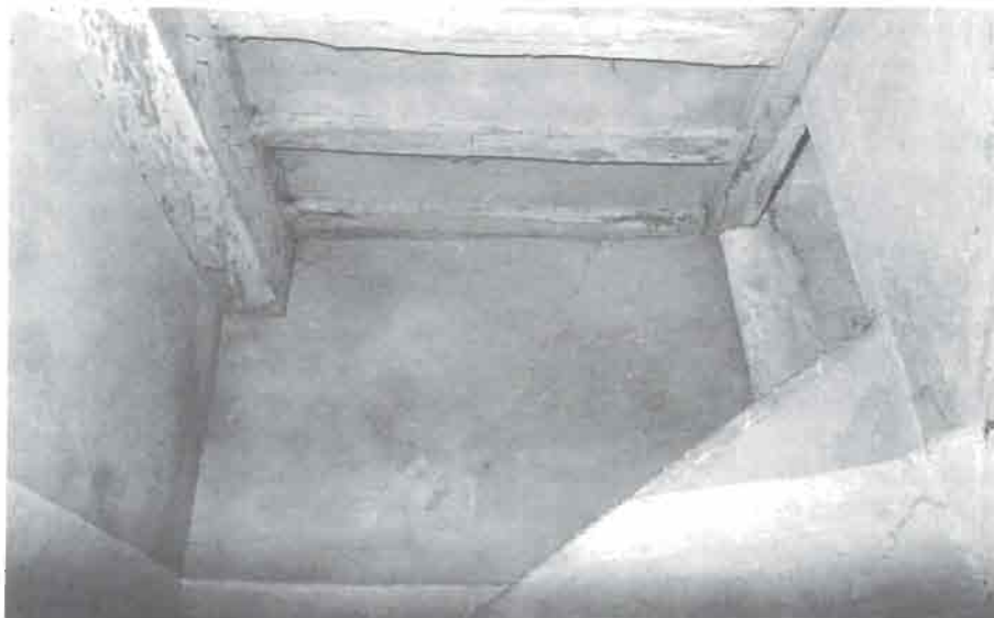
FOTO 59. Forjado de la segunda planta de la Torre.
