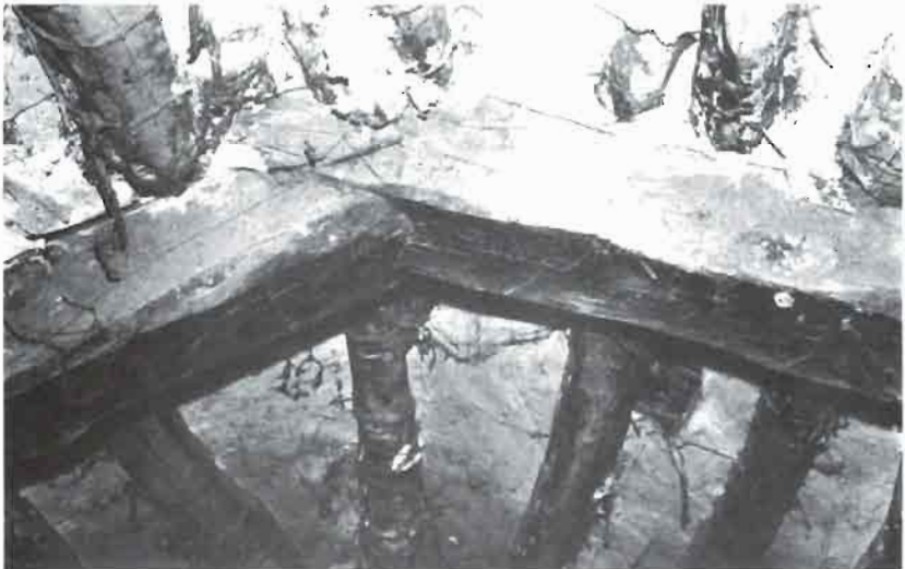
FOTO 55. Detalle de la intersección de los pares de una cercha de la Venta del Puerto.
