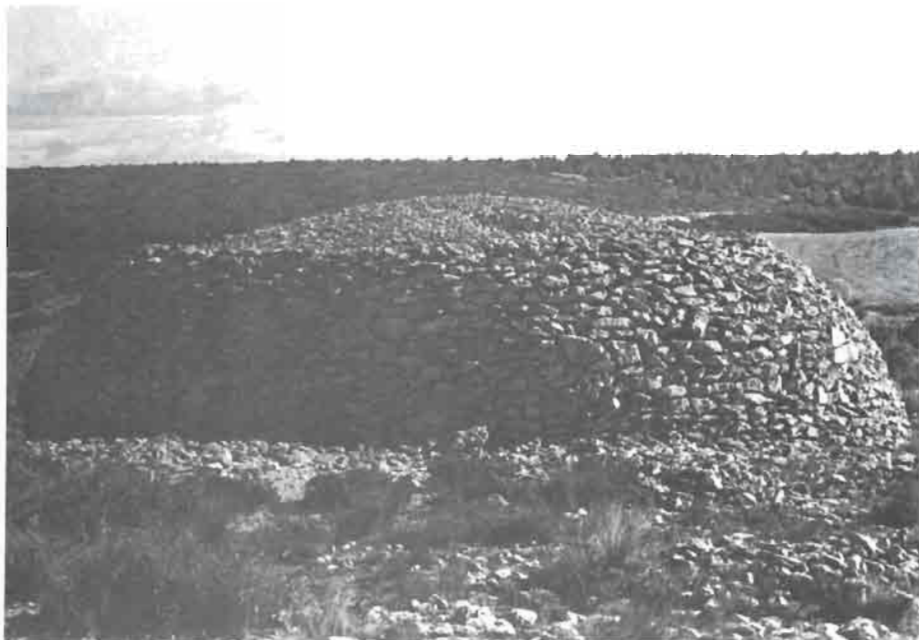
FOTO 82. Vista posterior de un cuco, donde se aprecia la capa de pequeñas piedras que lo cubren.
