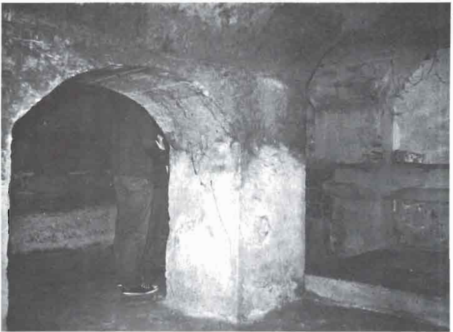
FOTO 26. Arcos en la bodega de la C.V. de los Crespos.
