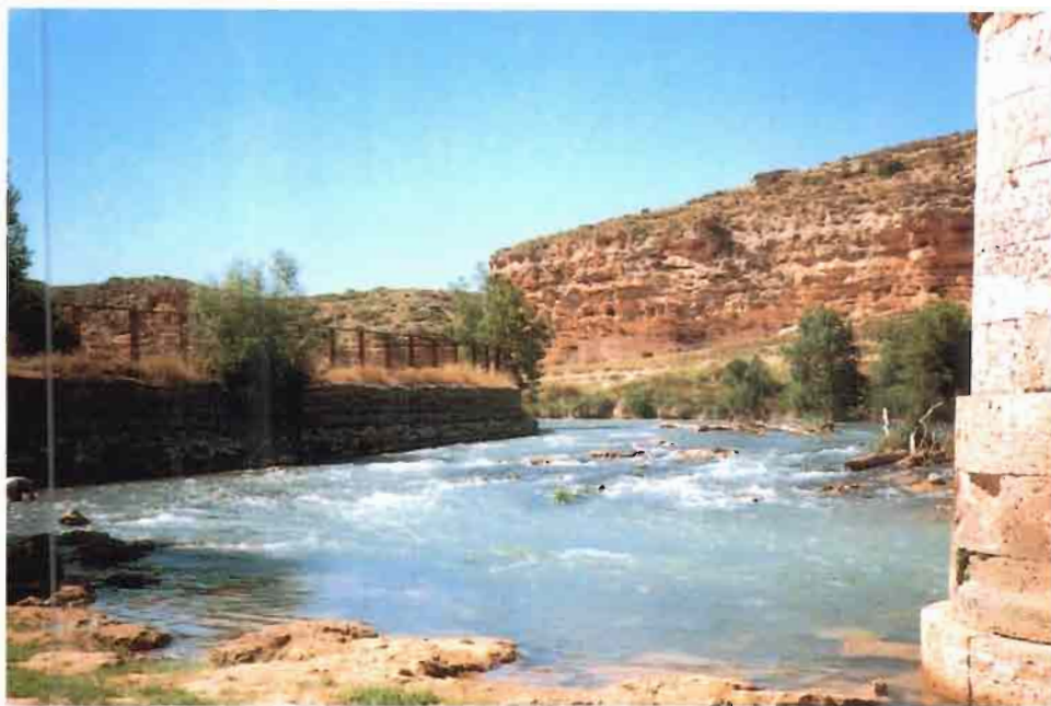
Estación J-4: Puente carretera de Motilleja.
