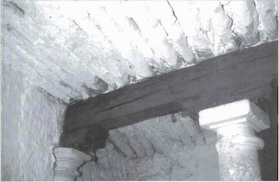
Letur. La madera utilizada en construcciones antiguas sirve para extrapolar los árboles disponibles y su calidad en aquella zona.
