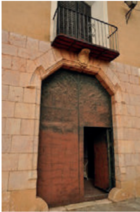
Vista completa de la puerta principal, rodeada de piedra de sillería, con su escudo episcopal y su balcón central. Palacio de los obispos de Orihuela en Caudete. Año 2015. Autor: Joaquín Medina.
