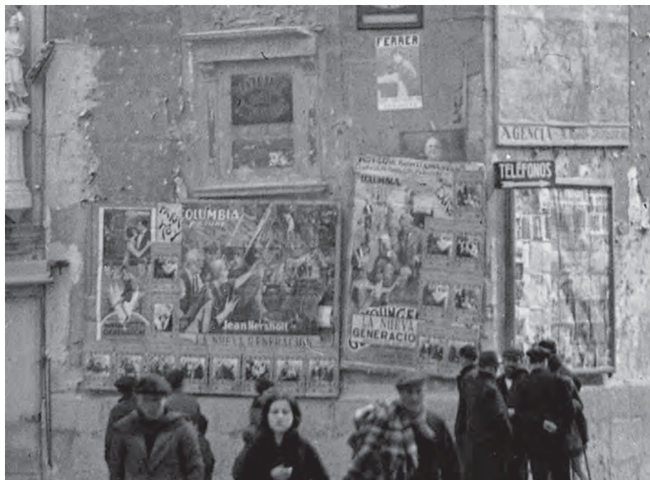
[2.12.] Detalle de la imagen de la Torre del Reloj con los carteles cinematográficos de La Nueva Generación .
