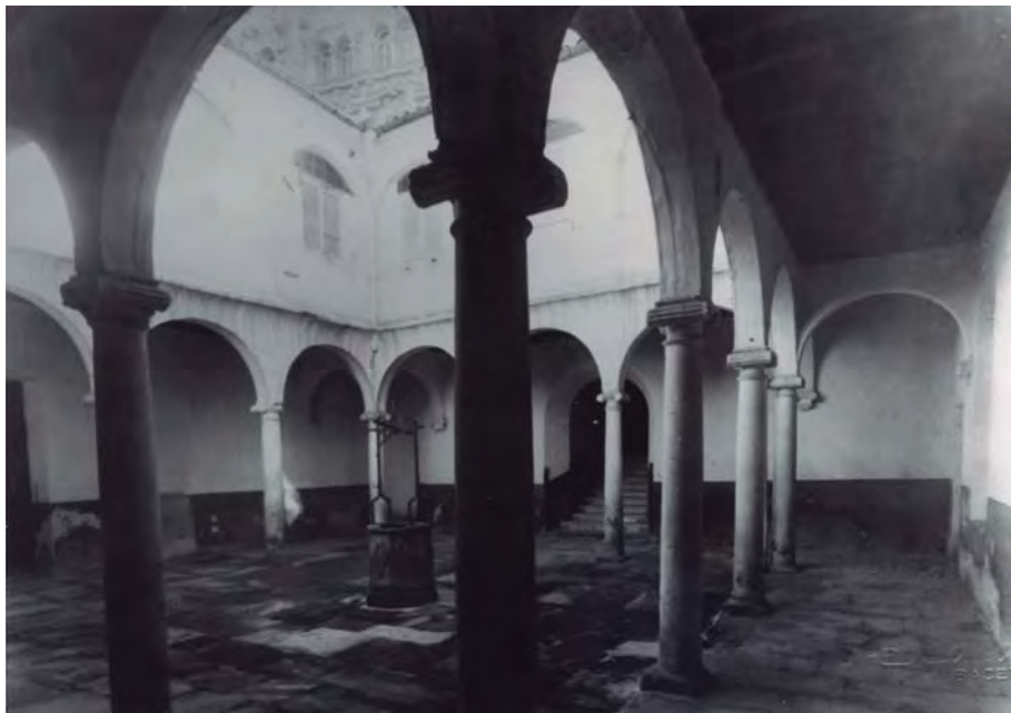
[6.14.] Patio interior del Palacio de Pinohermoso. (Fotografía: Archivo Instituto de Estudios Albacetenses)
