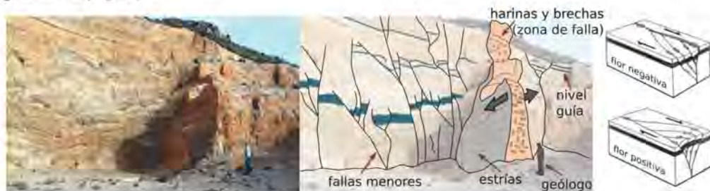
Figura 5. Falla de salto en dirección en la cantera de Puerto Lope.
