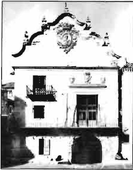
Fachada barroca del Ayuntamiento, (S. XVI).
