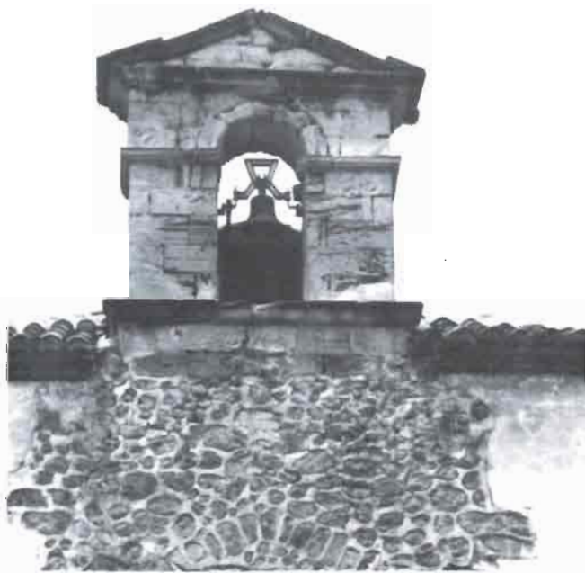
Fot. 7: Espadaña del convento de San Francisco. (Fot. V. Carrión).
