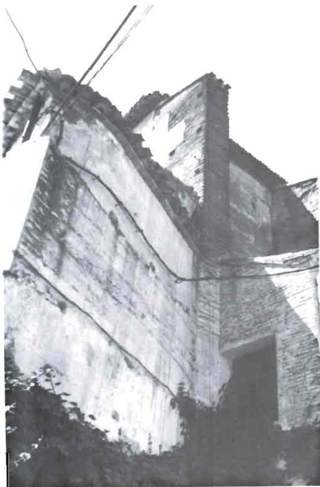
Fot. 20: Detalle del exterior, antes de la restauración de 1988. (Fot. V. Carrión).
