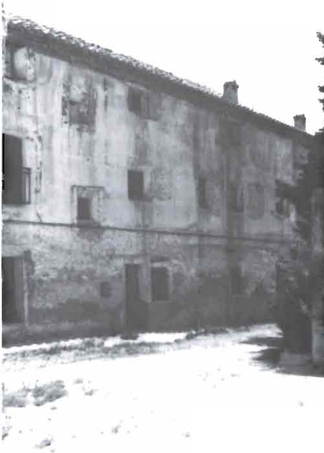
Fot. 8: Aspecto externo de las dependencias conventuales, en nuestros días bastante alteradas debido a las sucesivas reformas que sufrió el convento. (Fot. V. Carrión).
