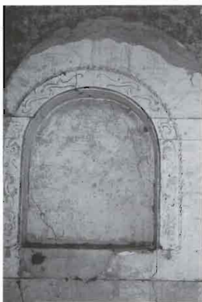
Fot. 45. HORNACINA DE LA GALERÍA DEL CLAUSTRO. Planta principal. Convento.
