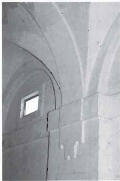
Fot. 44. MÉNSULA Y ARCOS DE LA GALERÍA DEL CLAUSTRO. Planta principal. Convento.
