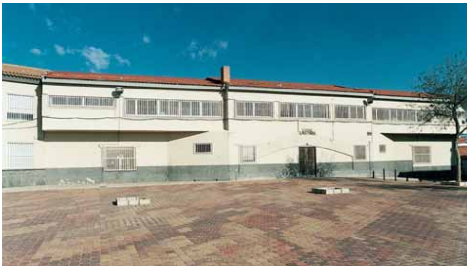
Colegio del “Ave María”, imagen actual de lo que fue la fachada posterior del Comedor Escolar del Auxilio Social “San Francisco”. (Fotografía del autor).
