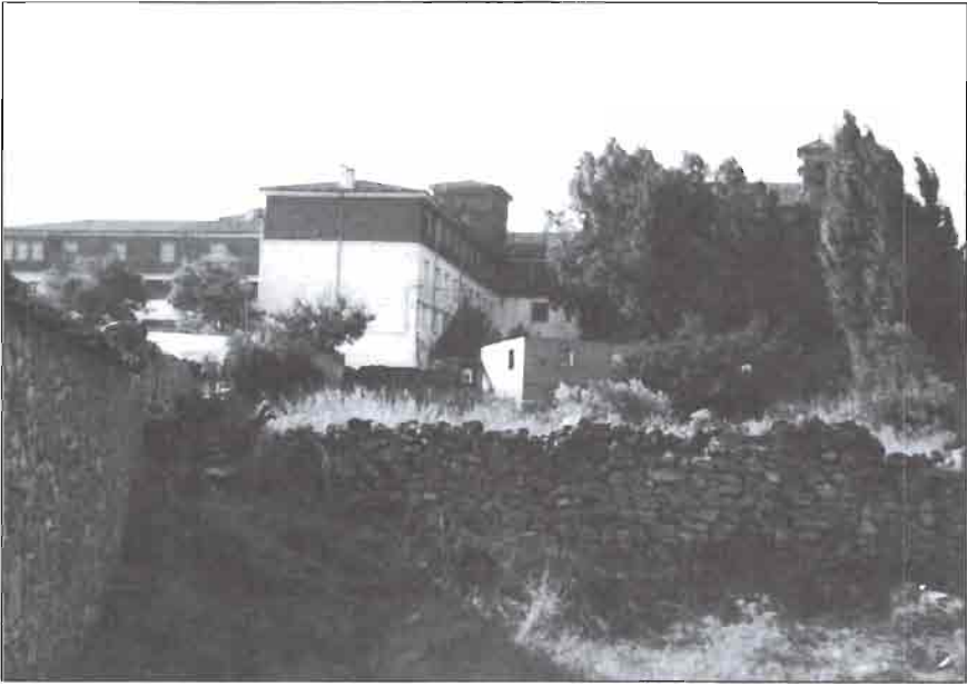
Foto n.º 8. Actual colonia del Santuario del Sahúco construida en el antiguo convento. Lado norte.
