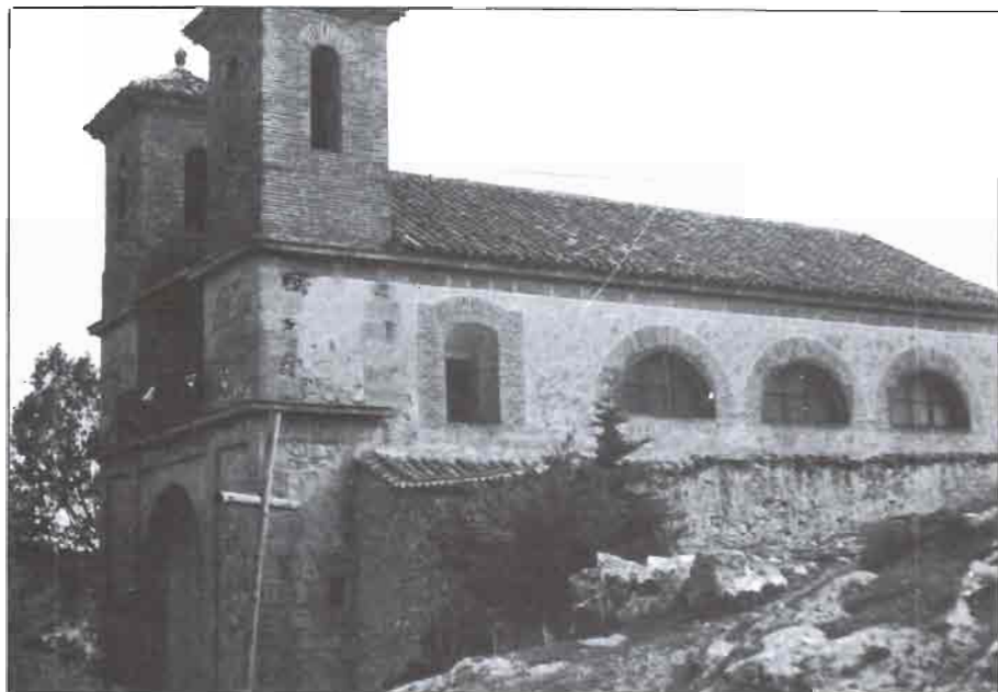
Foto n.º 11 Fachada meridional del cuerpo de la nave de la iglesia.
