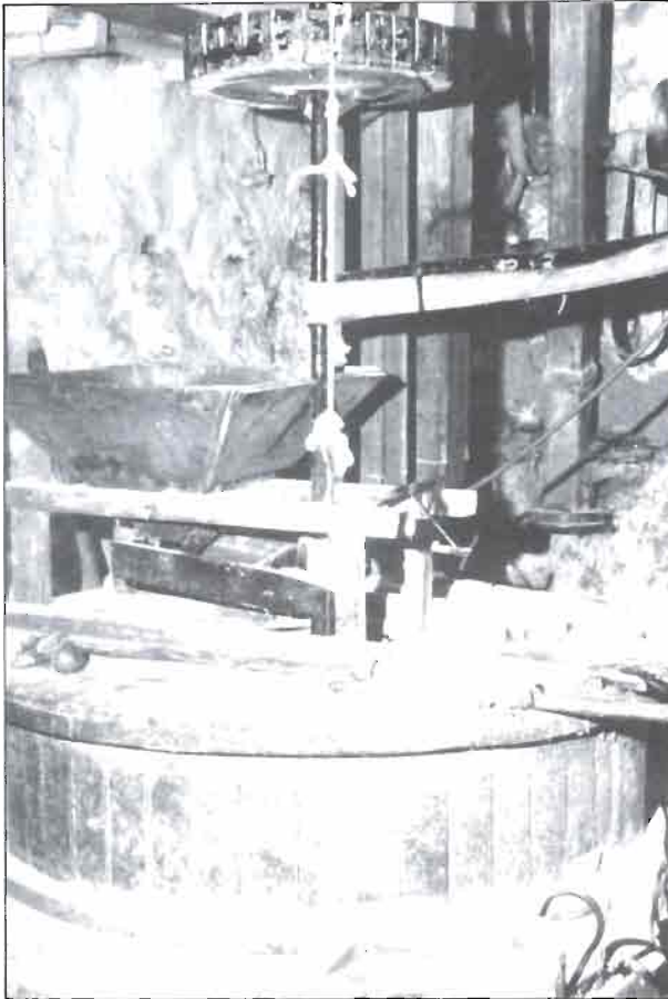
Foto n.º 25 Instalaciones y mecanismos intactos de un molino de grano en Nerpio. En pleno funcionamiento.
