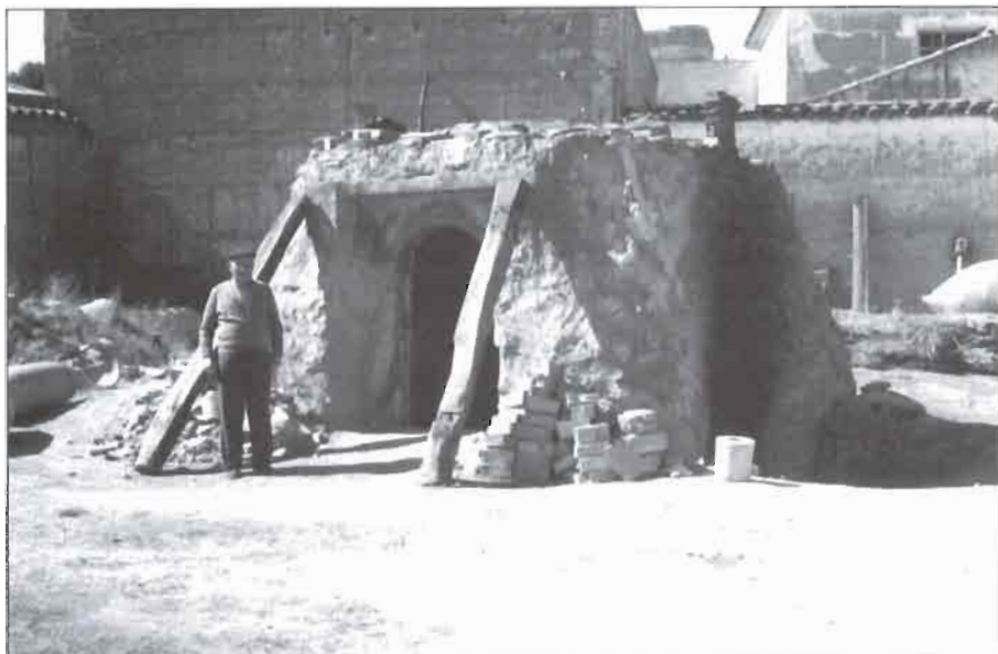
J. Gimena ante el pequeño horno o «garlito» construido actualmente para la cocción de las pequeñas piezas que fábrica. (Fot. García Gómez).
