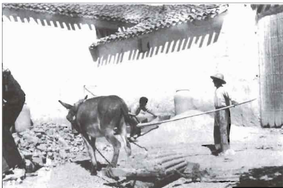
Molido del barro según el método tradicional con rulo estriado. Detrás de la pequeña era de molido aparece en la izquierda el barro sin moler —«en gasón»— y el molido, que un operario está cribando.
