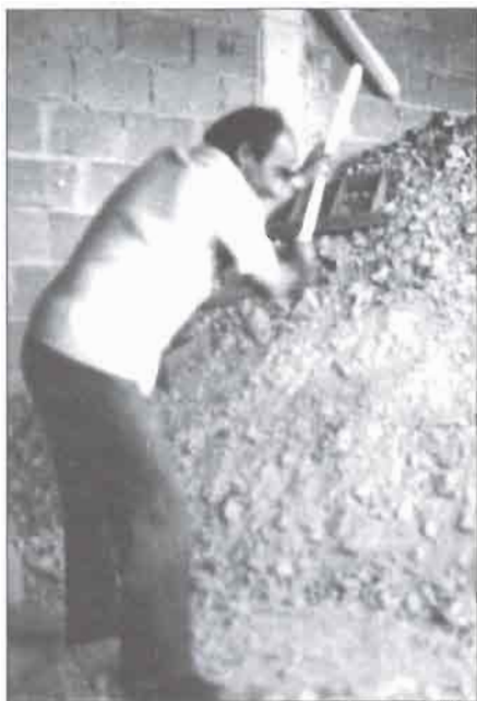
A. Padilla moliendo barro con una palanca, al antiguo uso. (Fot. cedida por A. Padilla).
