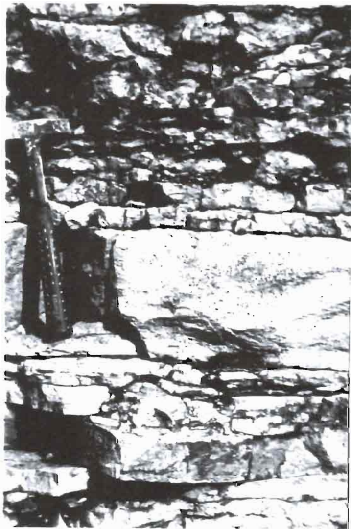
Fotografía III.3 Ciclos estrato-crecientes de bancos tableados de calizas. El martillo yace sobre un banco grueso que pone fin a uno de los ciclos, comenzando a techo el siguiente ciclo.
