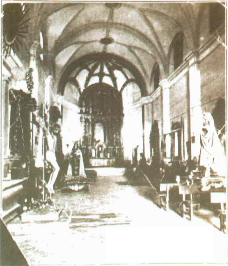
Interior de la Iglesia de Justinianas. Foto hacia 1935. Propiedad Particular.
