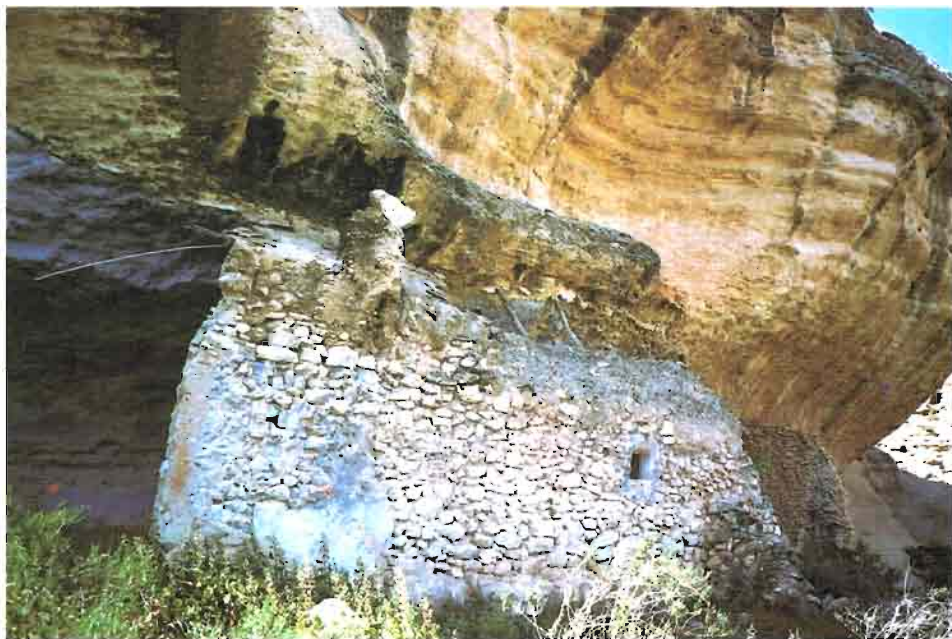
Foto 4. Cubrición a un agua de una casa semi-rupestre (casa B).
