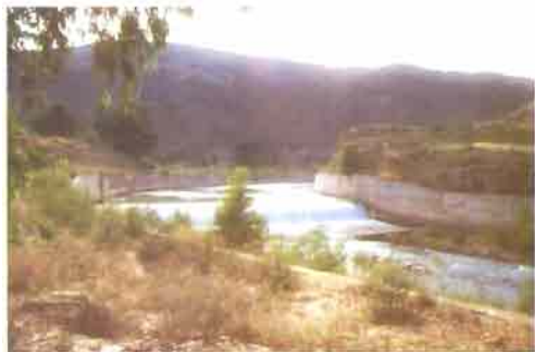
Tramos de río encauzado
