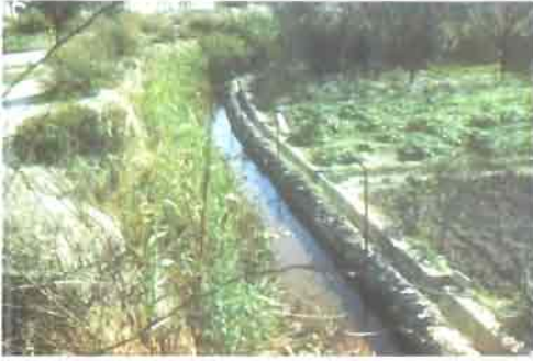
Acequias y canales de riego
