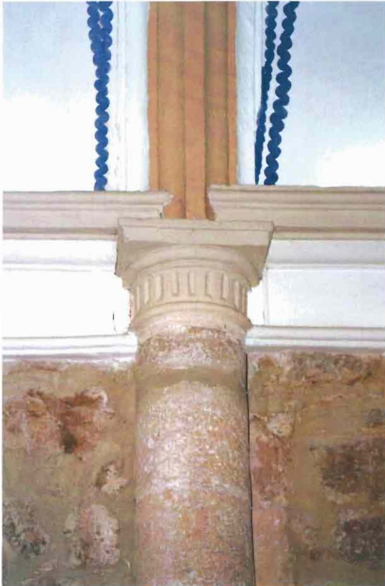
Fot. 11. Iglesia parroquial de Nuestra Señora de las Nieves, Cenizate. Interior. Semicolumna y arranque del arco del lado de la epístola.
