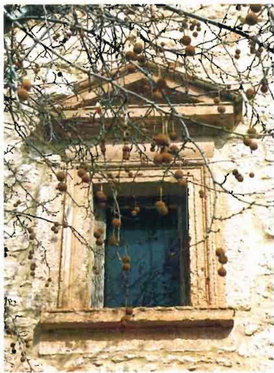
Fot. 7. Iglesia parroquial de Nuestra Señora de las Nieves. Cenizate. Exterior. Una de las ventanas de la fachada sur.
