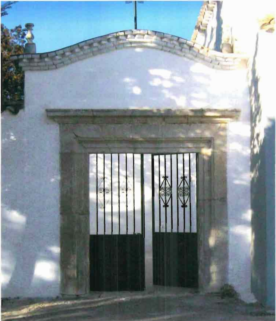
Fot. 74. Ermita de San Esteban, Cenizate. Puerta antigua de la ermita y actual del cementerio.
