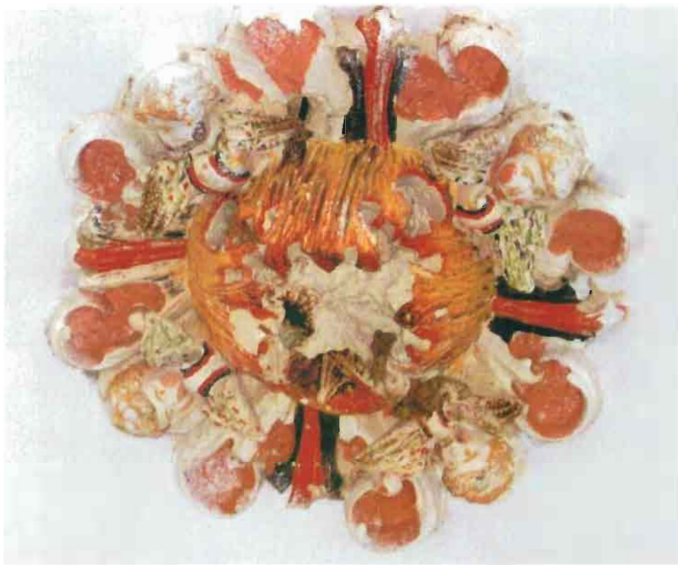
Fot. 73. Ermita de San Esteban. Cenizate. Clave pinjante de la bóveda del presbiterio.
