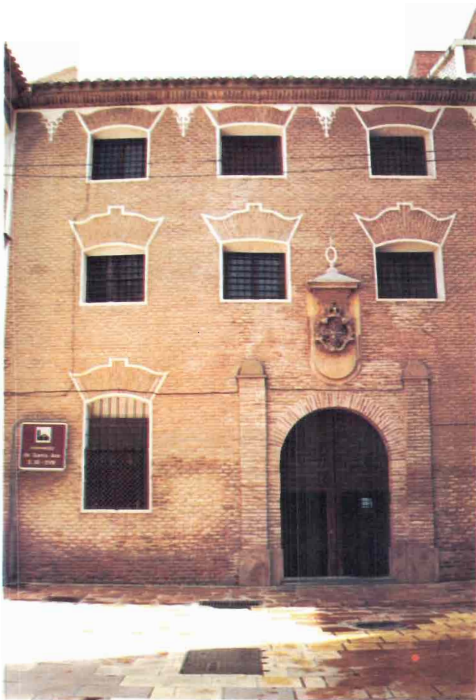
Acceso al Convento de Santa Ana (Murcia)
