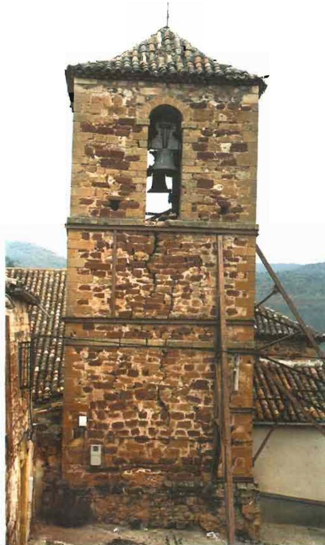
Fot. 2.- Torre de la iglesia de San Miguel. Siglos XIII o XIV. Alcaraz. Seguramente es el más antiguo campanario provincial pero su estado de conservación es tan lamentable que amenaza ruina. En él están colgadas, al menos, dos campanas antiguas, pero hace más de diez años que no hay escalera para subir a ellas.
