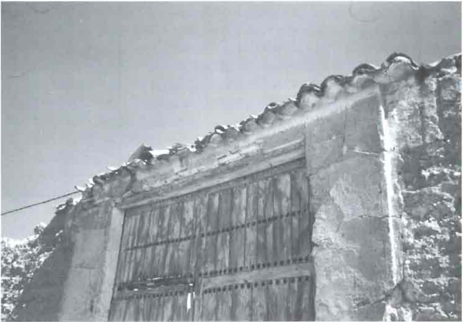
1.17 Portás , acceso tradicional al área de servicio de una vivienda tradicional.
