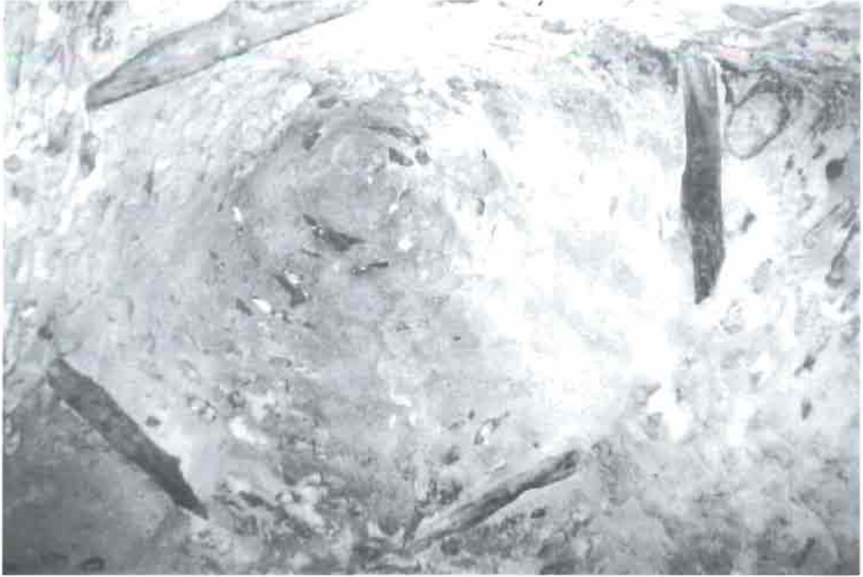
1.6 Detalle de la cubierta de un chozo.
