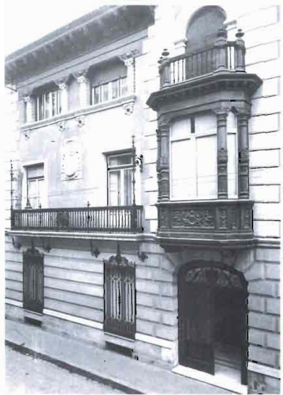
Fachada del edificio del Obispado en el momento de su inauguración. (Foto: Belda).
