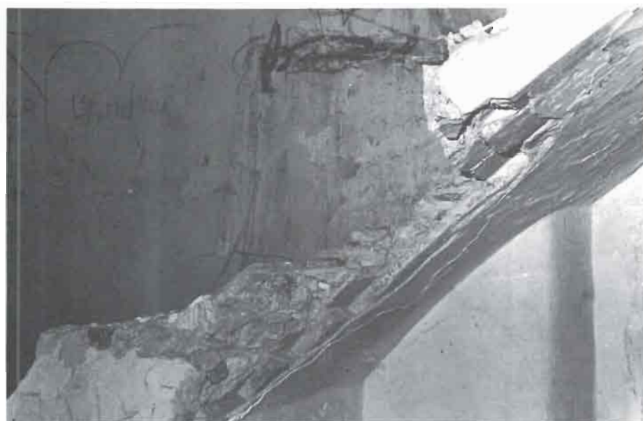
FOTO 20. Escalera en el Molino Alto.
