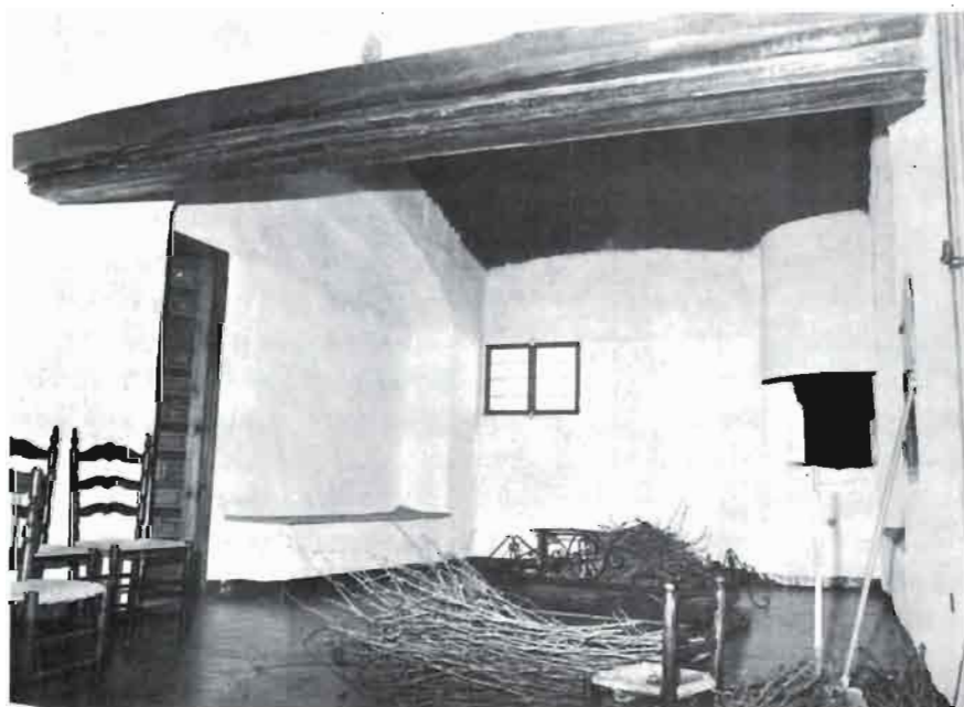
FOTO 56. Vista interior de la chimenea de la Venta del Puerto.
