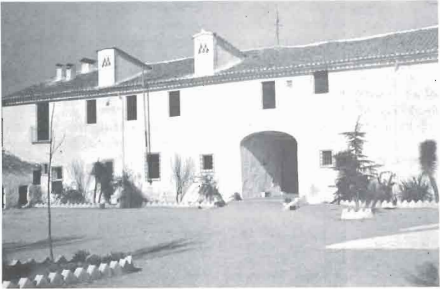
FOTO 53. Vista desde el interior del patio de la Venta del Puerto.
