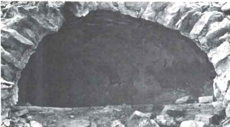
FOTO 6. Bóveda del horno del Corral de los Losares.
