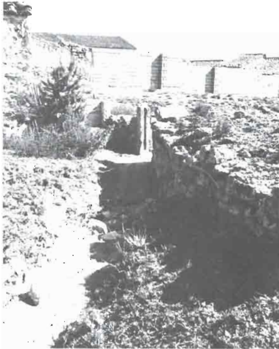
FOTO 1. Entrada de agua al aljibe de la C.V. de los Crespos.
