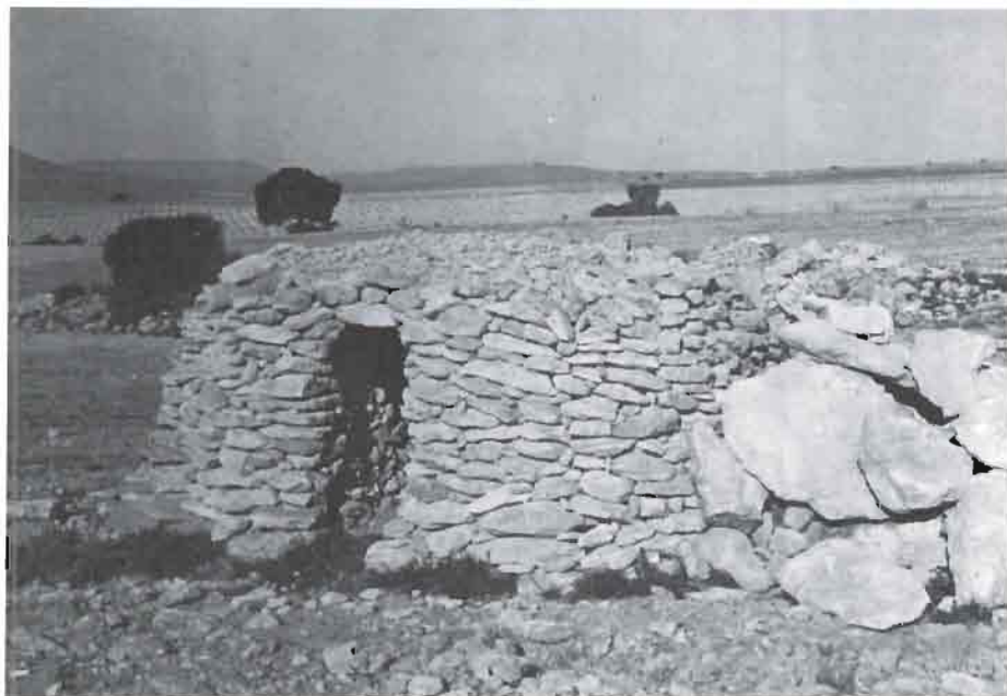
FOTO 86. Vista de un mal llamado Cuco en el paraje de Sugel.
