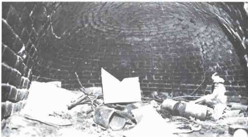
FOTO 7. Bóveda del horno de la Casa Vieja de los Crespos.
