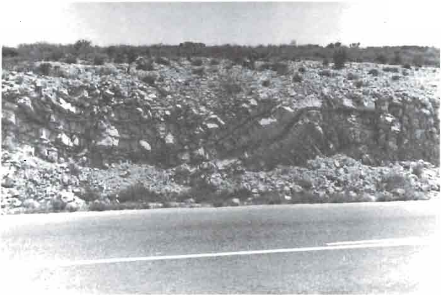
Foto n.º 8: Anticlinal de tipo encofrado y sinclinal en el Jurásico de la parada n.º 4.
