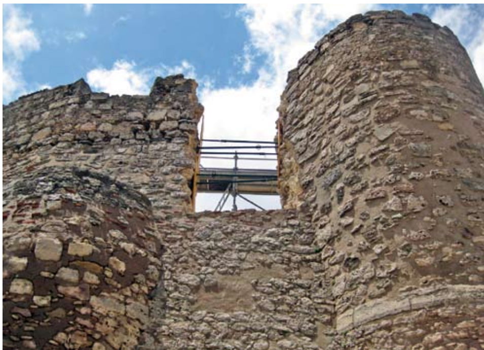
Fig.22. Reconstrucción de la puerta cegada, ubicada cercana a la torre del homenaje.
