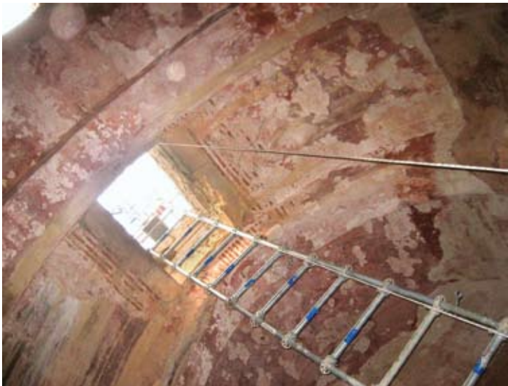
Fig. 20. Cubierta del aljibe ubicado en la zona central del recinto fortificado.
