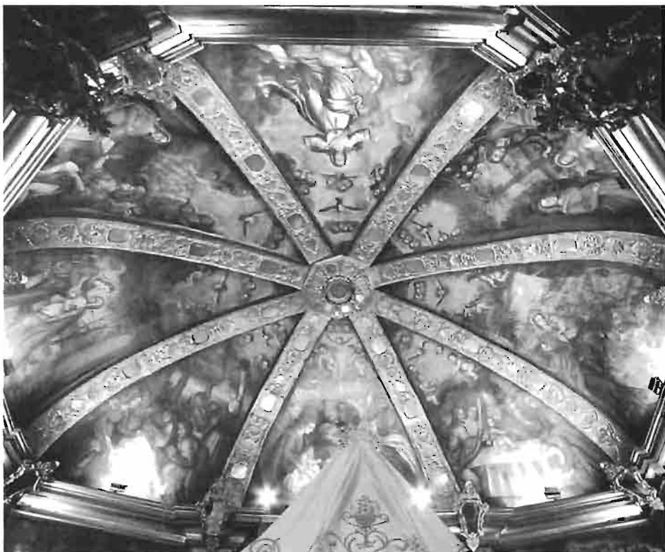
Fot. 20.- Santuario de la Virgen del Rosario. Hellín. Camarín. Vista de la bóveda. (Fot. S. Vico).
